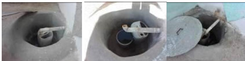
**Figura 2.** Tubo de PVC de 2 pulgadas conectado al piso en el lugar de escurrimiento del lixiviado. El mismo puede girarse en el momento de cambio de caneca o recipiente cuando ésta se ha llenado, para evitar pérdidas de lixiviado.
